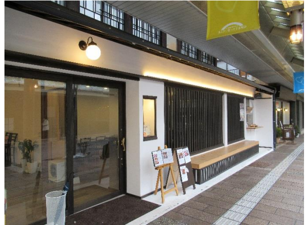
長い壁面が単調にならないよう、連子格子により分節化された例
